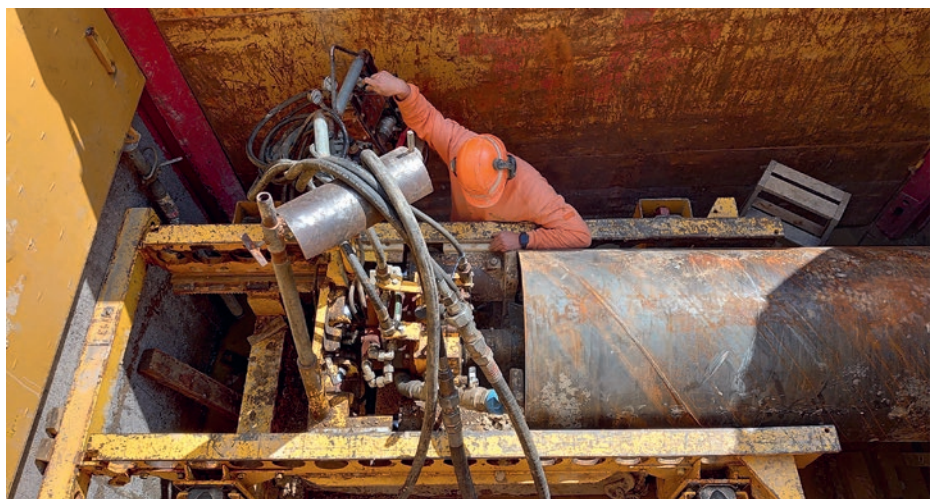
Von der Startgrube aus wird das Schutz- oder Vortriebsrohr von > 800 mm durch das Erdreich gepresst.
