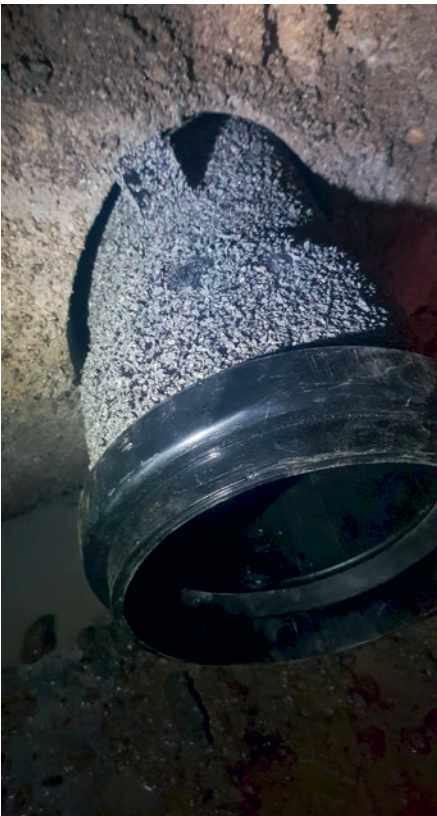
Das Anschlussstück wird sauber eingebaut und befestigt.
