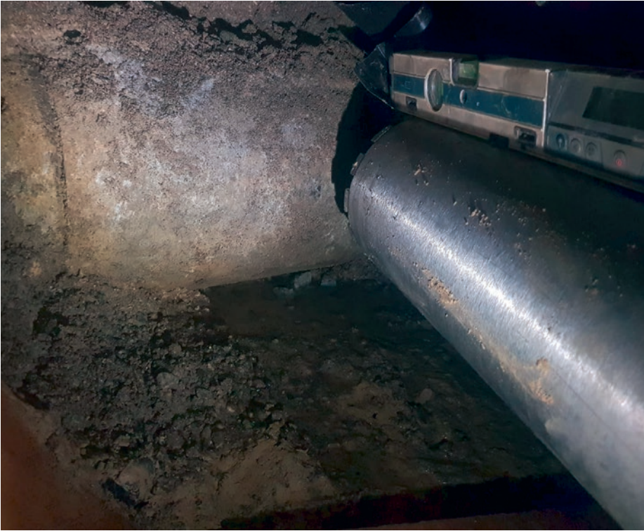
Mittels einer Kernbohrung wird der Anschluss in die bestehende Leitung gebohrt.
